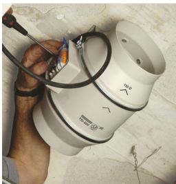
Réaliser les connections.
