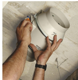
Insérer le corps moteur-hélice.
