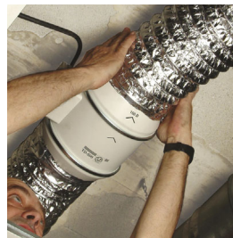
Raccorder les conduits.
