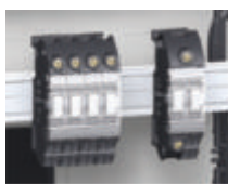
Het klemmenblok kan worden omgevormd in een eindverdeler tot 125 A met behulp van de steun PRA90048
