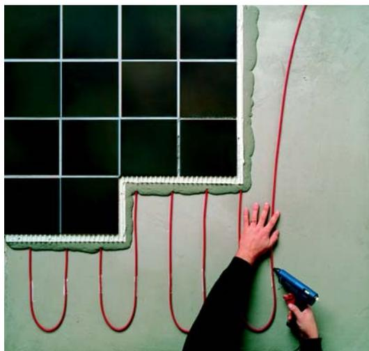
T2Red est un ruban chauffant autorégulant de faible épaisseur pour le chauffage par le sol. Il s'installe sous tous les types de revêtements, sans risque de surchauffe. Le ruban chauffant intelligent est idéal pour un confort accru partout dans la maison, de la salle de bains à la chambre.
