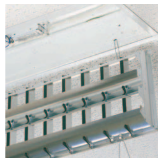
Systeme d'accrochage de l'optique
