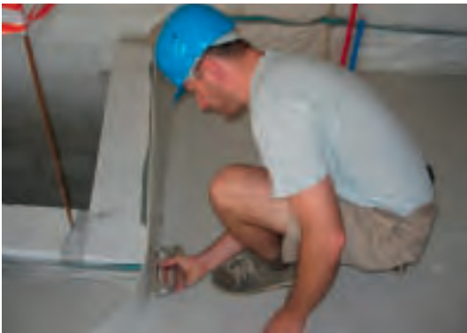
Pose isolant périphérique
