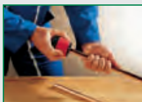
2 Le tube doit être ébavuré tant à l'intérieur qu'à l'extérieur.
