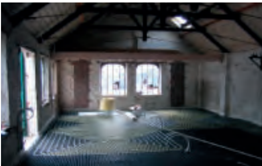
Exemple d'une rénovation avec chauffage par le sol
