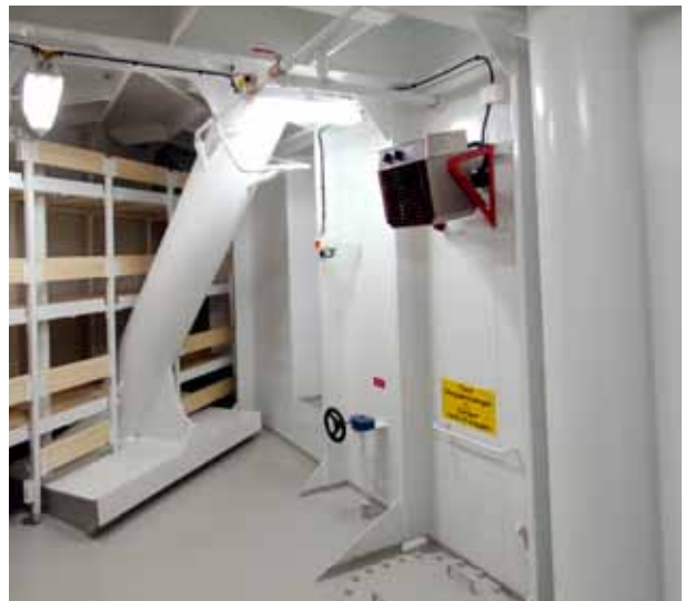
Les vibrations à bord des navires et des plateformes pétrolières peuvent entraîner des dysfonctionnements de l'équipement électronique. L'aérotherme Elektra V a été conçu pour résister à ces contraintes.
